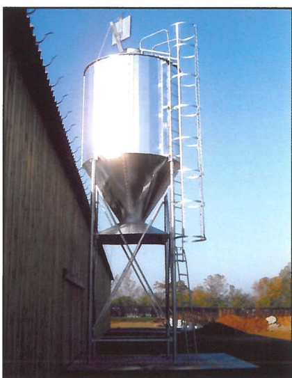
Silo tôle galvanisée
