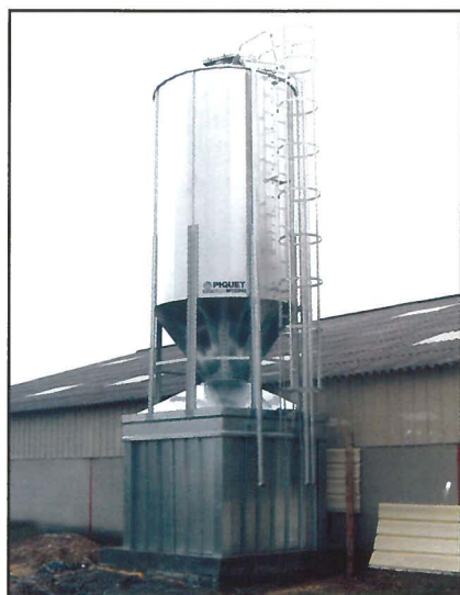
Silo 3 aliments avec soufflerie
