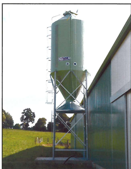
Silo avec rehausses pieds et toiture de protection des tuyaux
